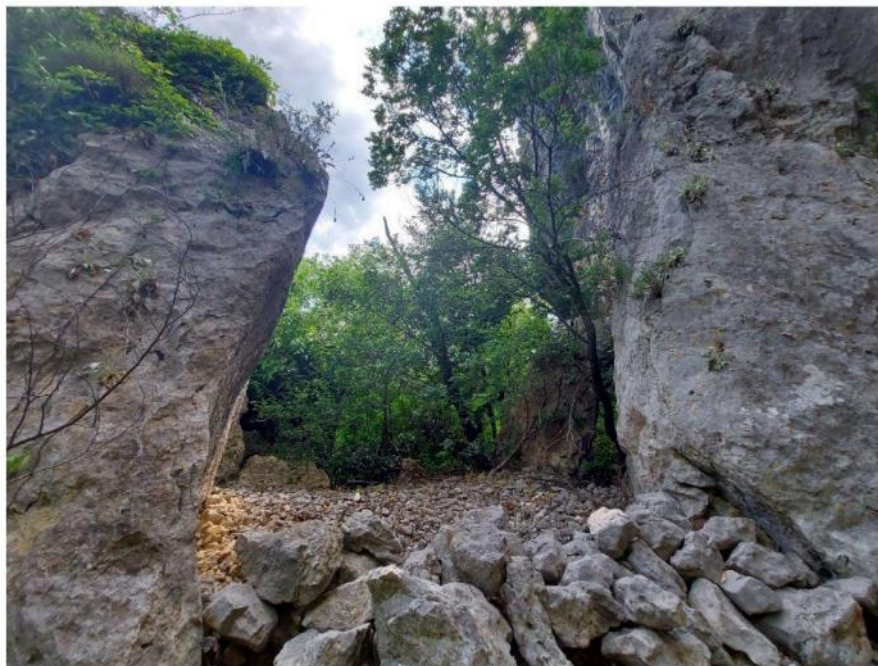
Slika 16 - Usjekline u stijenama sa sjeverne strane polušpilje Dobra voda
